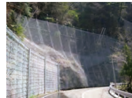
落石防止工(落石防護網)
