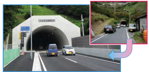
【(国)378号 依津バイパス 依津玉津トンネル】
