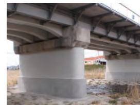
橋脚補強 (コンクリート巻立)
