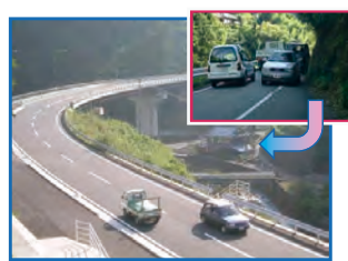
【(国) 379号 岩谷バイパス 新千里口橋付近】
