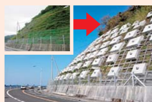
(国)378号 法面防災対策(大洲市)
