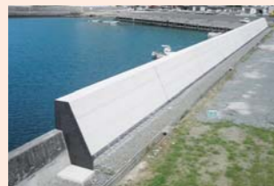
三崎港海岸(伊方町)
