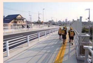
(主)壬生川丹原線(西条市)
