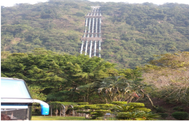
写真7：日月潭から5本の水圧鉄管により大観発電所（旧日月潭第一発電所）へ導水
