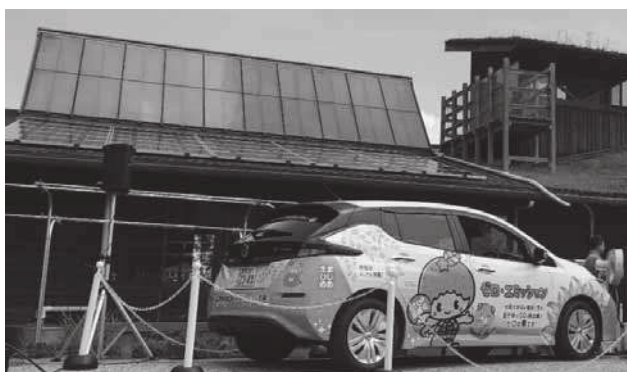
【EV 活用型蓄電システム】
