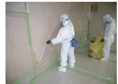
養生シートの撤去
