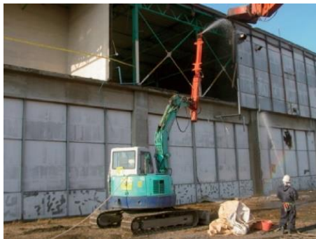
湿潤化の例(散水)
