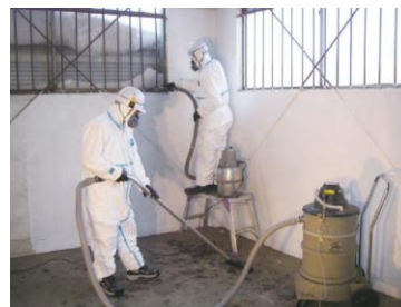
高性能真空掃除機を用いた作業場内の仕上げ清掃
