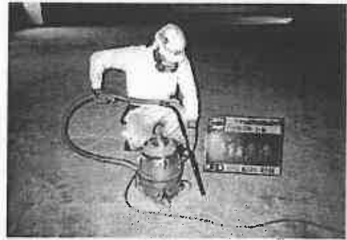
図 3. 115 清掃 高性能真空掃除機使用例
