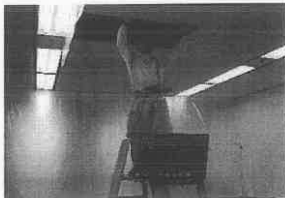
図 3.110 天井石綿含有成形板の除去例
