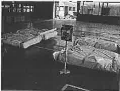
図 3. 116 石綿含有成形板廃棄物の保管例
