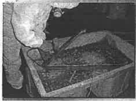
図 3. 118 掻き落とし除去作業の例
