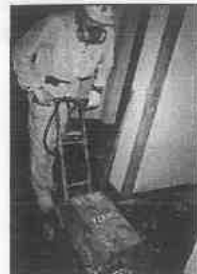
図 3.114 石綿含有ビニルタイルの除去例
