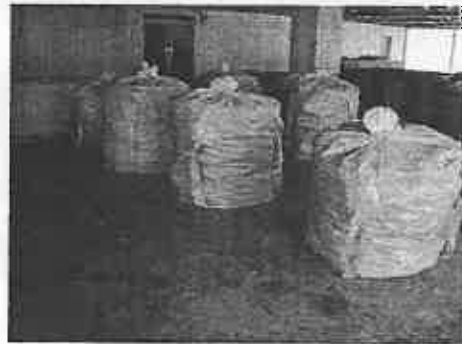
図 3. 116 石綿含有成形板廃棄物の保管例
