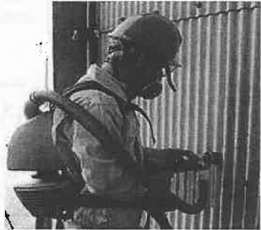
図 3.111 機械工具による切断例
