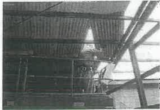
屋根スレート取外
