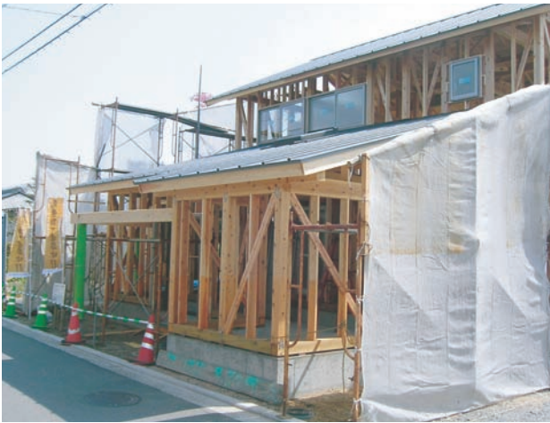
建築中、のほりを設置しPR中の住宅（松山市内）
