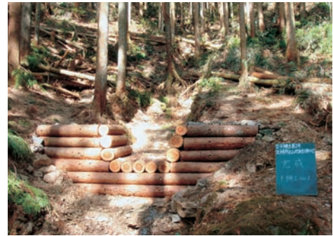
河川内に倒木した林木を利用した木柵工を整備した状況（西条市大保木里山）
