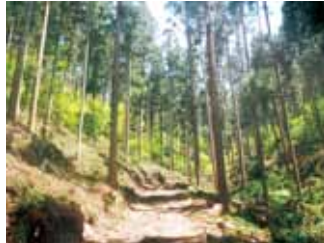
作業道の整備
