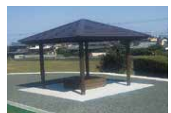
県営総合運動公園東屋の整備
