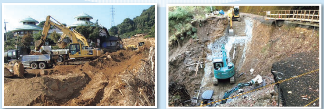
平成30年西日本豪雨災害の復旧工事の様子
