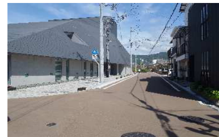
飲料水兼用型耐震性貯水槽
