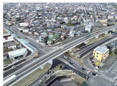
松山外環状道路「インター線」
