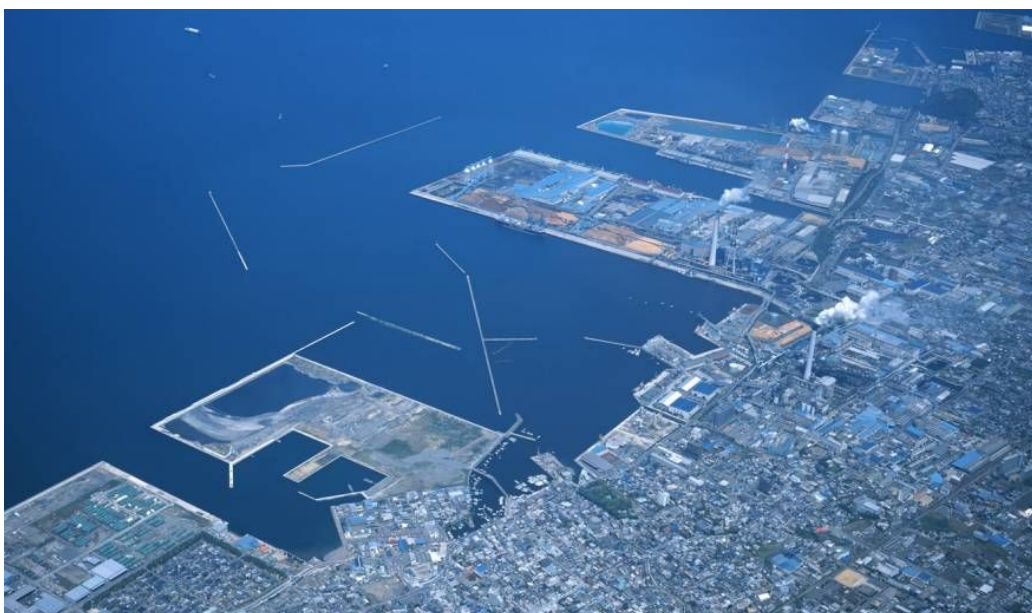
三島川之江港 航空写真 (平成18年3月)
