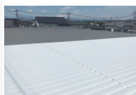
倉庫屋根 (群馬県)
