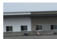
工場屋根と壁面 (愛媛県)
