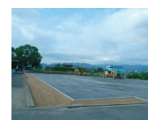
駐車場の造成工事
