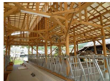
牛舎の補改修
