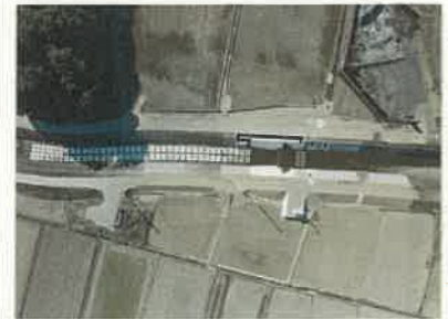
取水堰の改修
