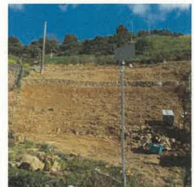
農家自主施工による緩傾斜化
