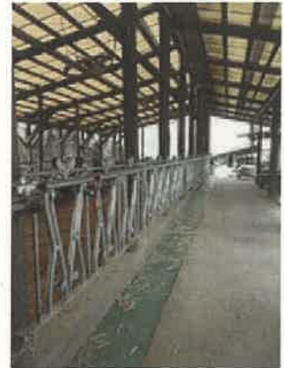
家畜係留器具の補改修
