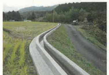
農業用排水路
