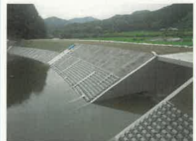
ため池の改修
