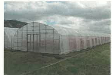
新設したいちごのハウス
