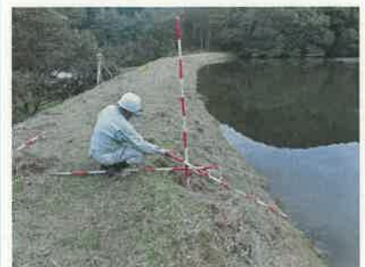
ため池の点検状況
