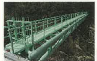
僧都川水管橋 塗装工事完成
