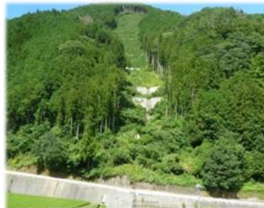
【山地災害跡地への 治山施設整備】
