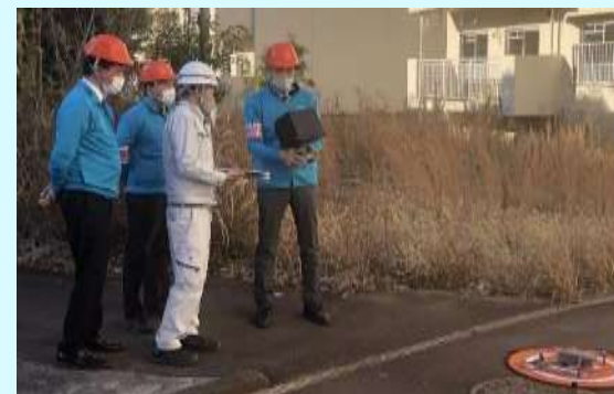
市営住宅の外壁状況をドローンで確認
