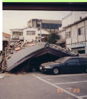
平成7年1月の阪神淡路大震災のときの被災写真です。
