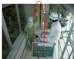
② 既存柱の内側にあと施工アンカーを施工する。
