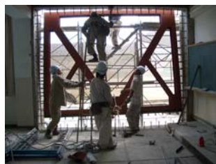
② 撤去後の構面内の柱及び梁にあと施工アンカーを施工し、ブレースを設置する。
