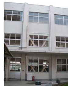
③ ブレースの内外に壁面及びサッシを復旧する。
