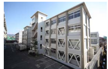
③ 外側補強工法により鉄骨ブレースの設置
