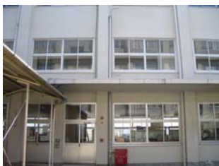
① 鉄骨ブレースを設置する部分の腰壁、垂壁及びサッシなどを撤去する。
