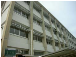
① 着工前状況
