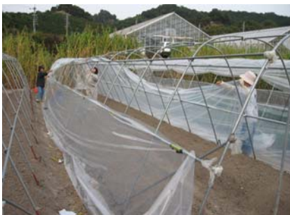
④サイドビニル、天ビニルの順に被覆し、パッカーで留める
